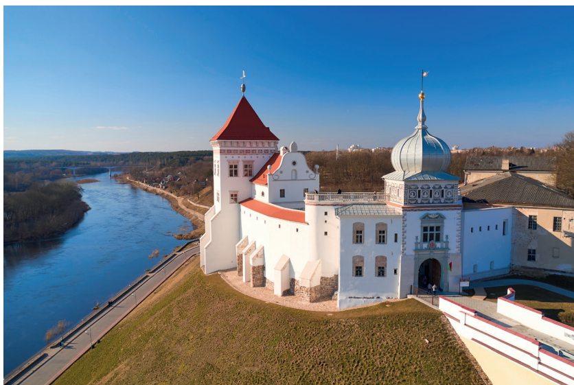
A rekonstrukció első szakasza utáni állapot
